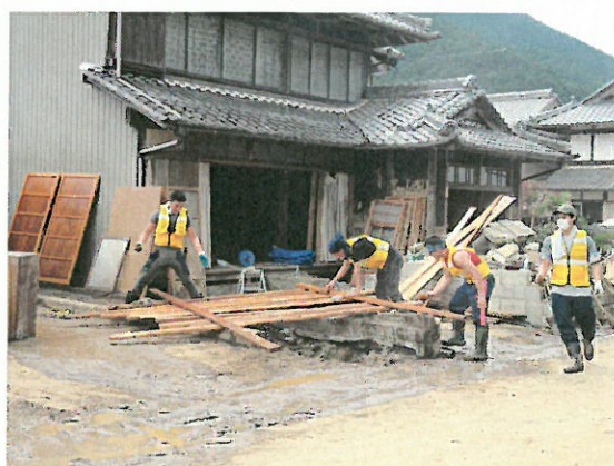
▲床上浸水した床を剥がして磨く作業を行う ボランティアの方々(関市上之保)
