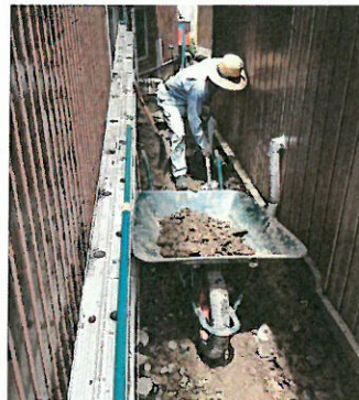
▲家屋の間に溜まった土砂を掻きだす作業を行うボランティア（下呂市金山町）
